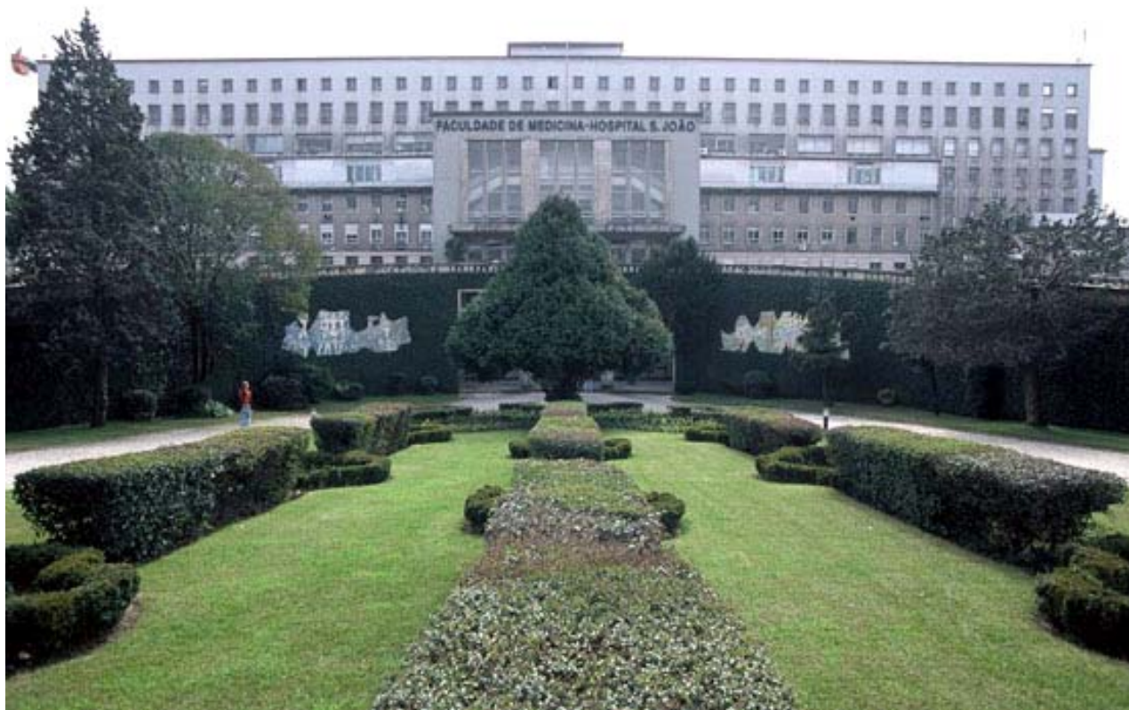
Hospital São João, Porto
